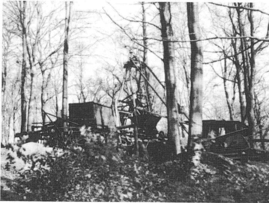
Abb. 10: Kleinzeche im Weitmarer Holz, um 1956. In der Bildmitte: Fördergerüst über dem Schacht. Die Kohle wurde dort aus den Fördergefäßen in auf Schienen fahrenden Wagen umgeladen.
