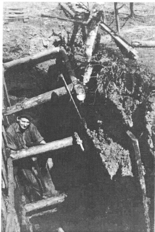
Abb. 9: „Abhauen“ (im Flöz abfallend hergestellter Grubenbau) einer Kleinzeche im Flöz Geitling an der Straße „Am Pferdestall“ in der Nähe der Gaststätte „Zur alten Tür“ im Muttental bei Witten-Bommern, 1950er Jahre.
