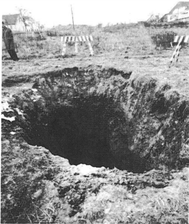
Abb. 3: Tagesbruch an der Weitmarer-Holz-Straße in Bochum-Weitmar, 18. Dezember 1964
