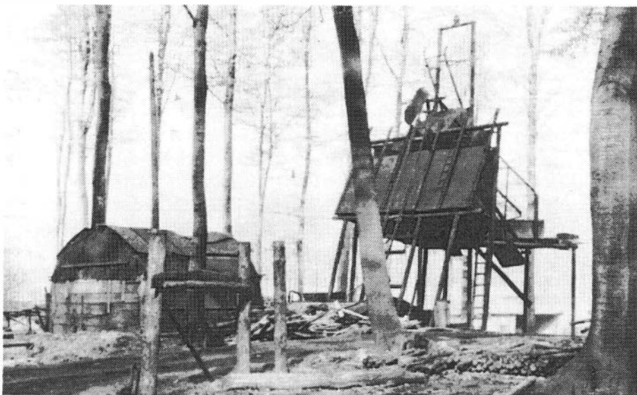
Abb. 5 (oben): Stollenbetrieb an der Blankensteiner Straße in Bochum-Haar, 1950er Jahre. Vom fahrbaren Druckluftkompressor aus führten Druckluftleitungen in den Stollen, um die Abbauhämmer der Bergleute zu versorgen. Für den Ausbau lag Grubenholz bereit.
