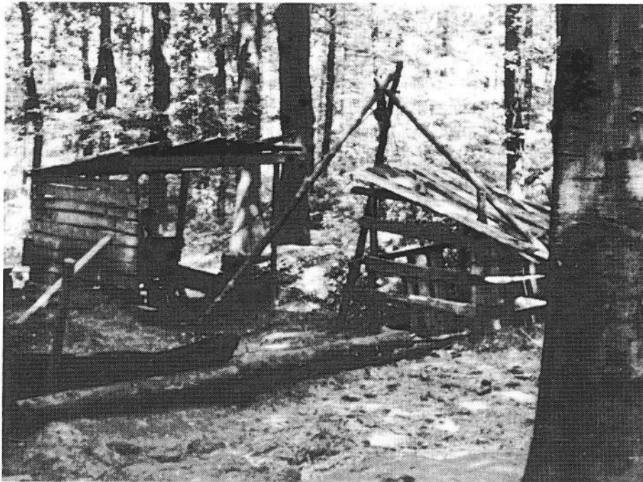
Abb. 7: Kleinzeche im Wald bei der Ruine Hardenstein im Muttental bei Witten-Bommern, 1950er Jahre. Vom Haspel (Seilwinde) aus, der unter einem Holzverschlag (links im Bild) steht, führt das Förderseil über eine Umlenkrolle oben am Dreibaum (Bildmitte rechts) in den darunter beginnenden Schacht.
