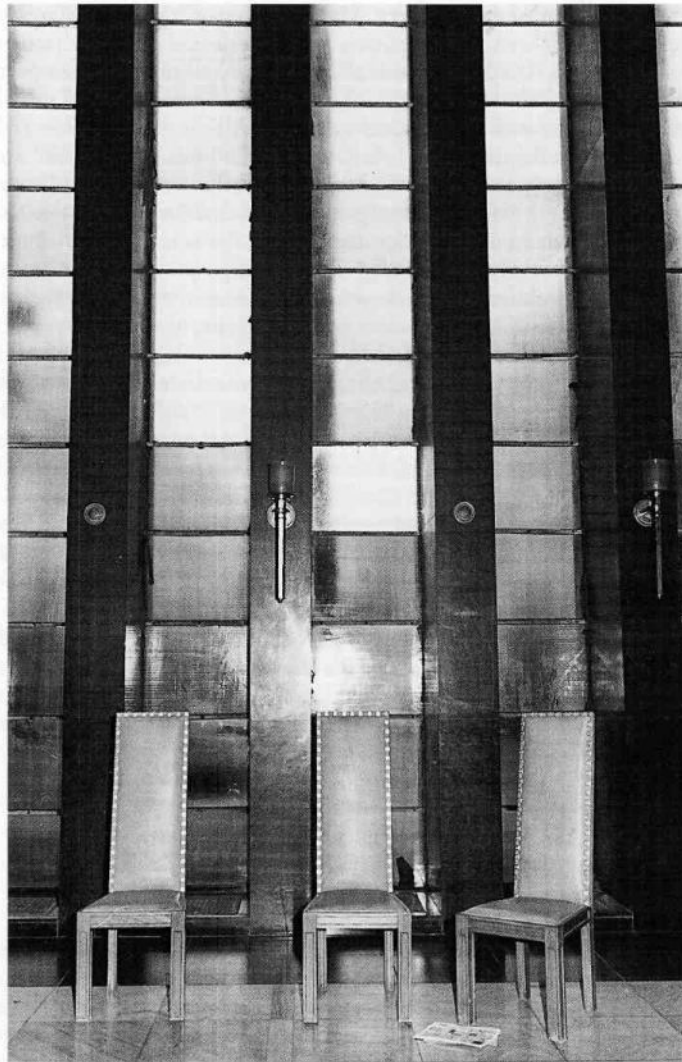
364 Große Halle, Kathedralverglasung 1949–1967, Zustand 1966
