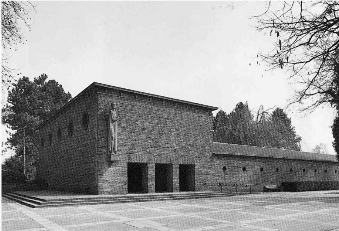
348 Kleine Trauerhalle vor Nordwesten, Zustand 1996
